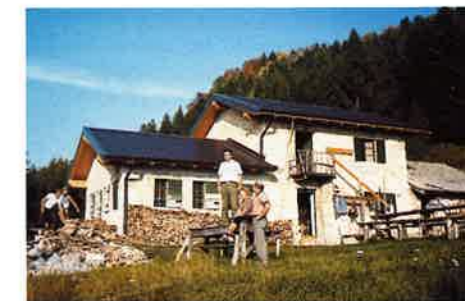
La malga in ristrutturazione 1986-89
