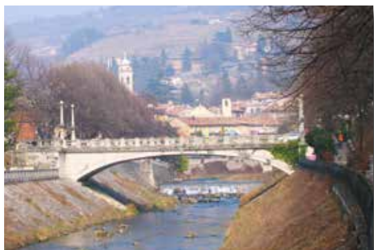
Il ponte di Rovereto che verrà rinominato "Ponte degli Alpini".
