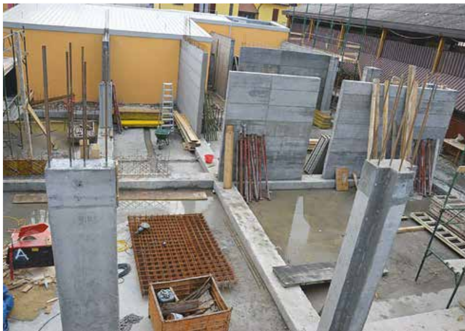
Il cantiere sta procedendo celermente. Nella foto sopra la situazione all'11 marzo, con molti pilastri e setti oramai realizzati.
