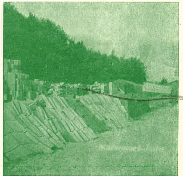
Deposito materiali vari nel Cantiere.
