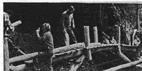
Il ponte rimesso in sesto dagli alpini (foto Spagolla).
